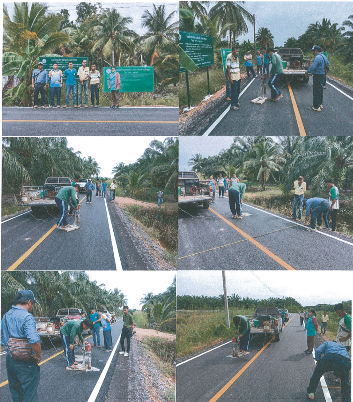
การตรวจรับพัสดุโครงการก่อสร้างถนนลาดยาง Asphalt Concrete รหัสทางหลวงท้องถิ่น นศ.ถ. 95-025 สายบ้านสระนอก - คลองเขต หมู่ที่ 8,4 บ้านสระนอก,บ้านพัทธสีมา ตำบลท่าซอม สถานที่ หมู่ที่ 8,4 ตำบลท่าซอม อำเภอดงหลวง จังหวัดนครศรีธรรมราช ประชาชนที่เข้าร่วมตรวจรับงานจ้างคือ นายเสรี หมื่นวรดี นายสุธรรม หนูทอง
